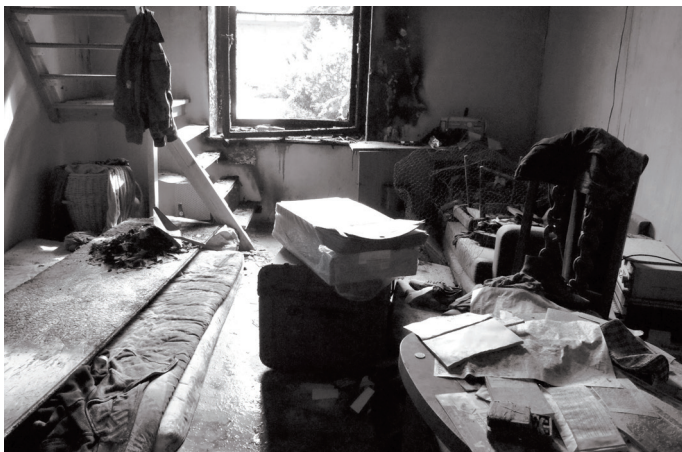
Nach dem Brandanschlag 2010 auf die Praxis.
